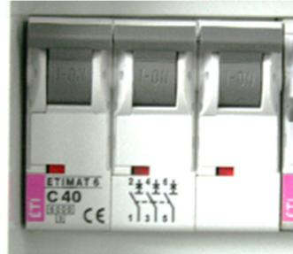
Interruttori magnetotermici dell'impianto per l'alimentazione del dispositivo aria-acqua (WPL, WPLV).
