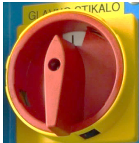
Hauptschalter der Wärmepumpe Sole-Wasser, Wasser - Wasser (WPG)
