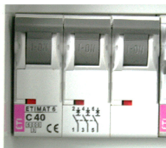
Inštalacijski odklopniki za napajanje naprave zrak–voda (WPL, WPLV).
