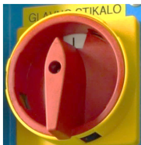
Glavno stikalo naprave zemlja–voda, voda–voda (WPG).
